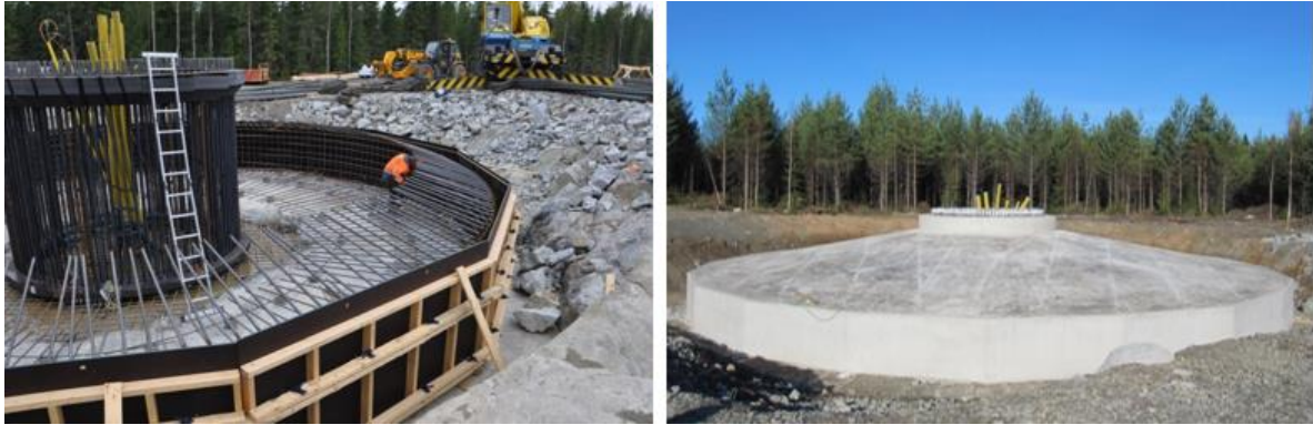
Kuva 99. Tuulivoimalan perustusten rakentamista (FCG Finnish Consulting Group Oy).
