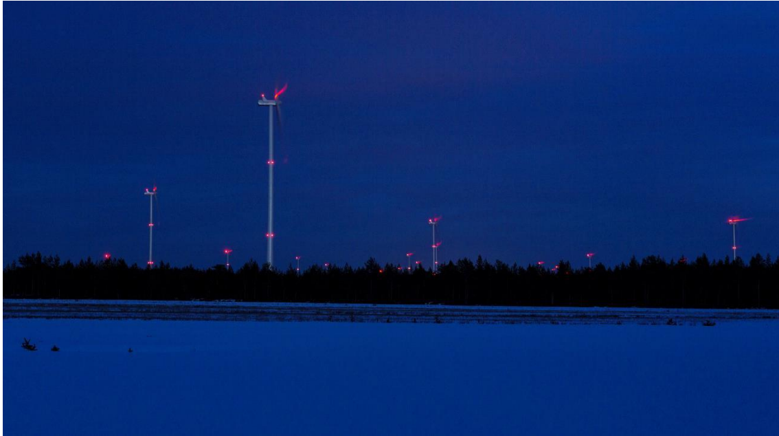
Kuva 94. Kiinteät punaiset lentoestevalot pimeällä. (Kuva: Ville Suorsa/FCG)
