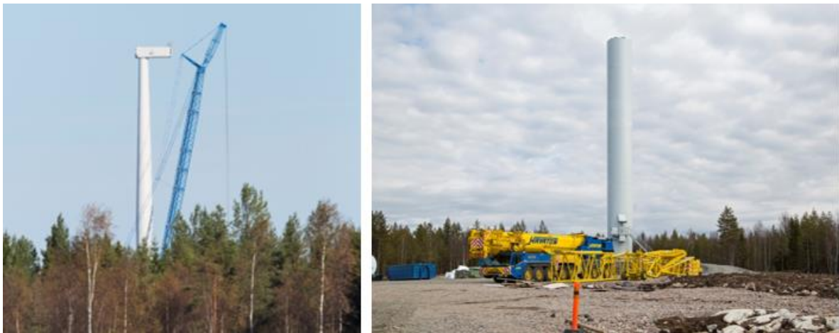
Kuva 100. Tuulivoimalan kokoamista (FCG Finnish Consulting Group Oy).
