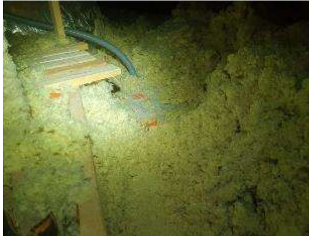
KUVA 52 OSA YLÄPOHJASTA LISÄLÄMMÖNERISTETTY
