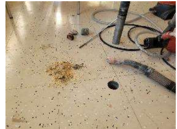
KUVA 113 VÄLIPOHJARAKENTEEN RAKENTEEN TUTKIMINEN.
