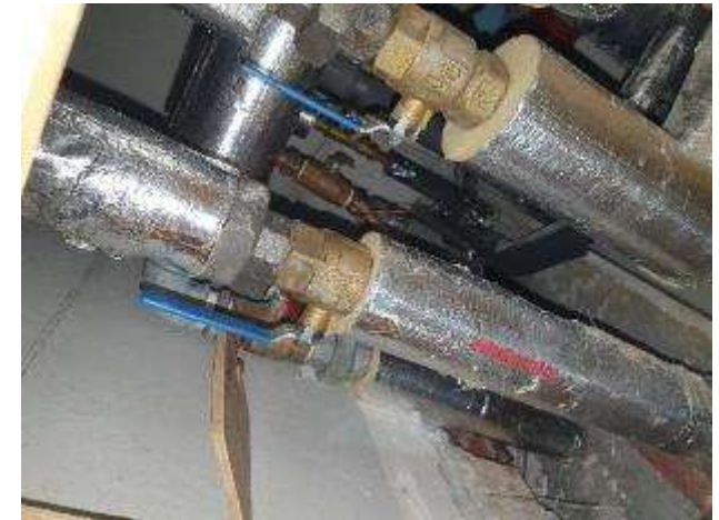
KUVA 85 2003 REMONTISSA UUSITTU OSA LÄMMITYS- JA KÄYTTÖVESIJOHDESTA
