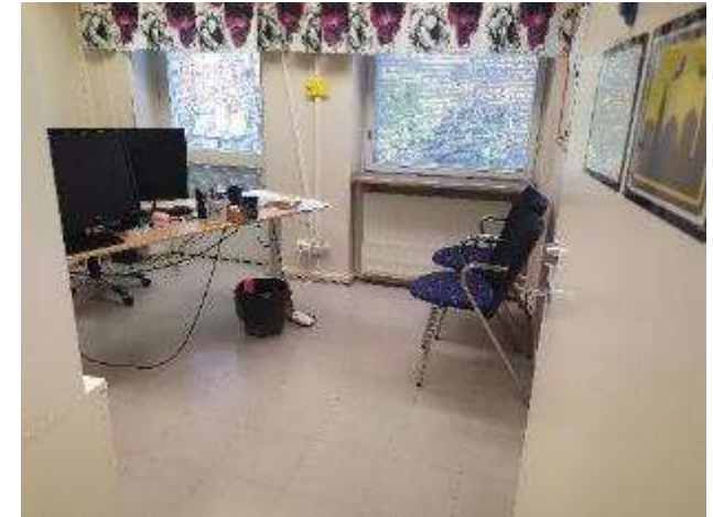
KUVA 62 TOISEN KERROKSEN TOIMISTOHUONE LÄHES ALKUPERÄISESSÄ KUNNOSSA. RADIAATTORI ALKUPERÄINEN.
