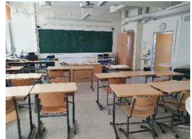
KUVA 63 LUOKKATILAN LATTIA- JA SEINÄPINNOITTEET SEKÄ ILMANVAIHTO UUSITTU 2003 REMONTIN YHTEYDESSÄ.
