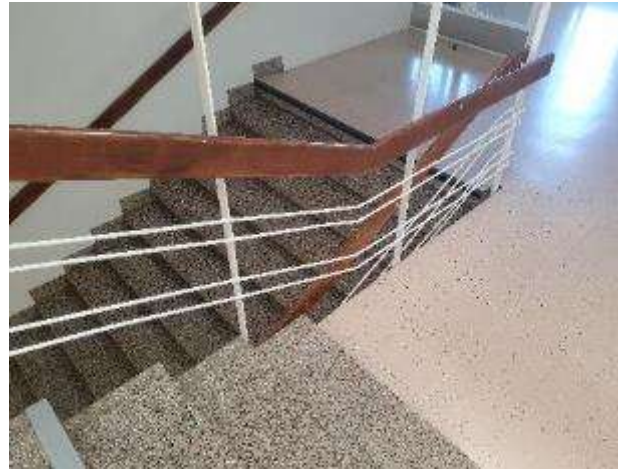
KUVA 60 PORRASKÄYTVIEN TASANTEIDEN LATTIAT UUSITTU 2003 REMONTIN YHTEYDESSÄ.
