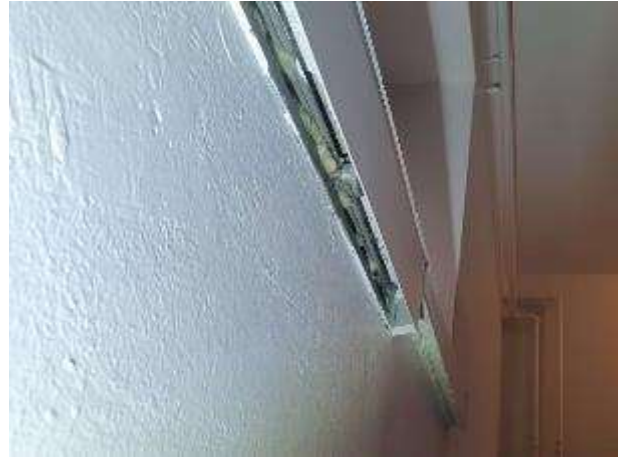
KUVA 82 ULKO-WC-TILOJEN KORVAUSILMAVENTTIILIT
