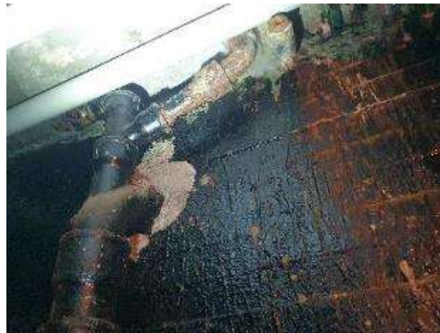
KUVA 77 OSA VIEMÄREISTÄ ON ALKUPERÄISIÄ VALURAUTAVIEMÄREITÄ.
