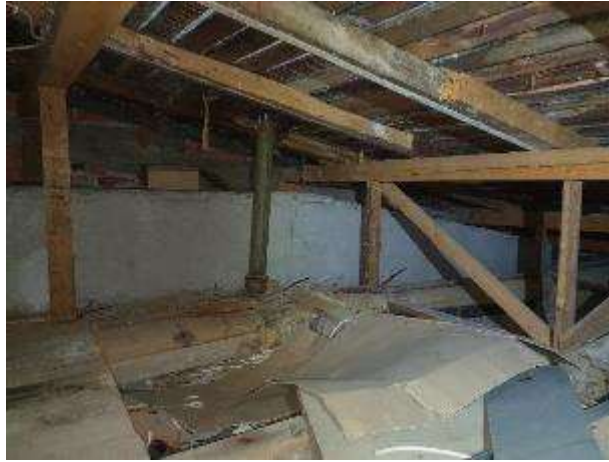
KUVA 51 1959 JA 1963 VÄLISEN ALKUPERÄISEN JA LAAJENNUSOSAN RAJAPINTA YLÄPOHJASSA.
