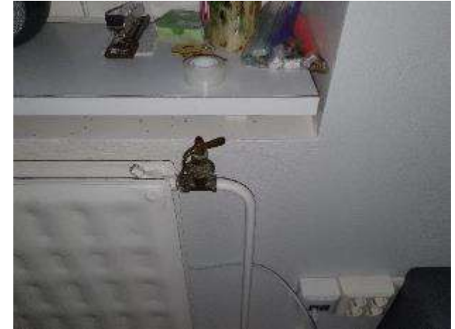
KUVA 84 OSA RADIAATTOREISTA ALKUPERÄISIÄ.
