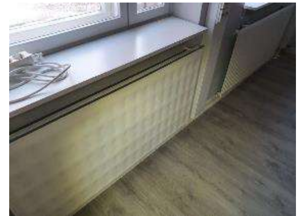
KUVA 107 OSA RAKENNUKSEN PATTERNVERKOSTOSTA JA RADIAATTOREISTA ALKUPERÄISIÄ.
