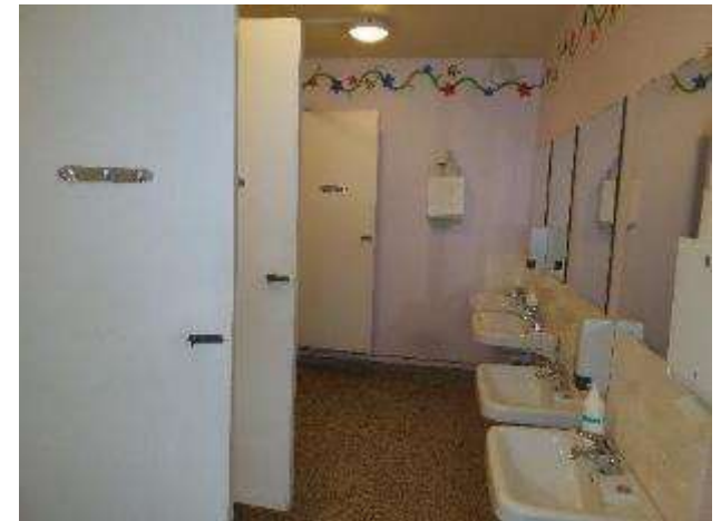
KUVA 57 ULKO-WC- TILAT ALKUPERÄISESSÄ KUNNOSSA.
