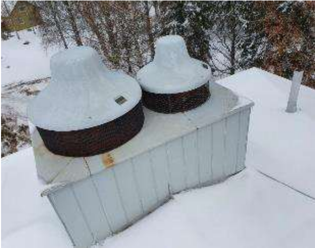
KUVA 80 LIIKUNTASALIN HUIPPUIMURIT ALKUPERÄISIÄ
