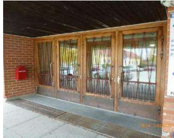
KUVA 41 ALKUPERÄISET PÄÄSISÄÄNKÄYNNIN ULKO-OVET
