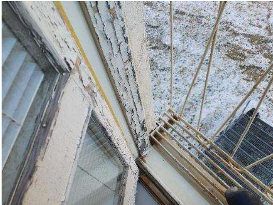
KUVA 40 RANSKALAISEN PARVEKKEEN PUINEN OVI ON HUONOSSA KUNNOSSA.
