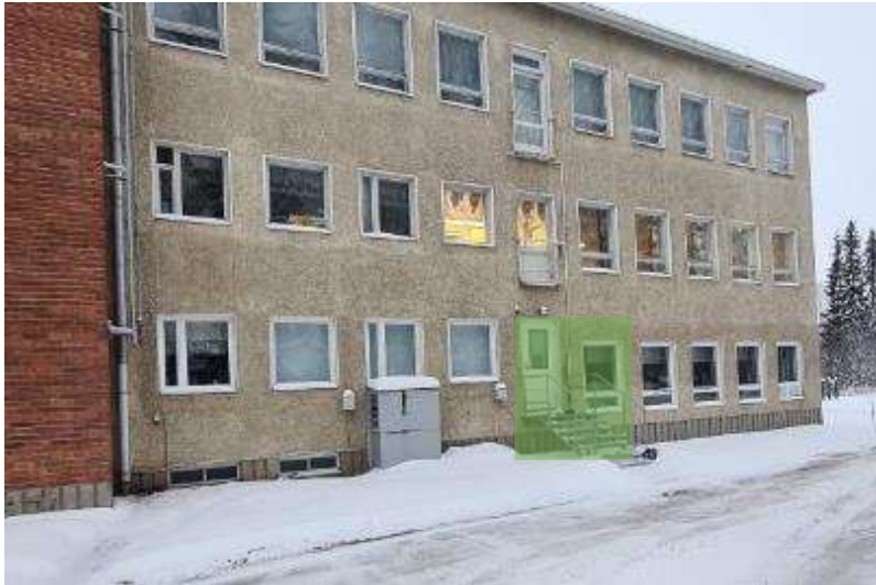
KUVA 39 UUSI ULKO-OVI JA RAPPUSET ON RAKENNETTU VUONNA 2015
