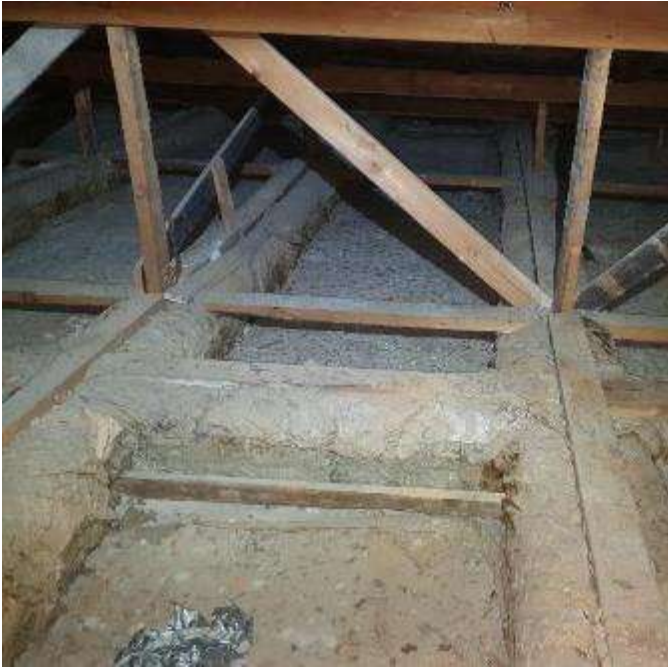
KUVA 49 VESIKATON KANNAKKEET PAIKALLA TEHDYT PUKKI-PALKKILINJAT.
