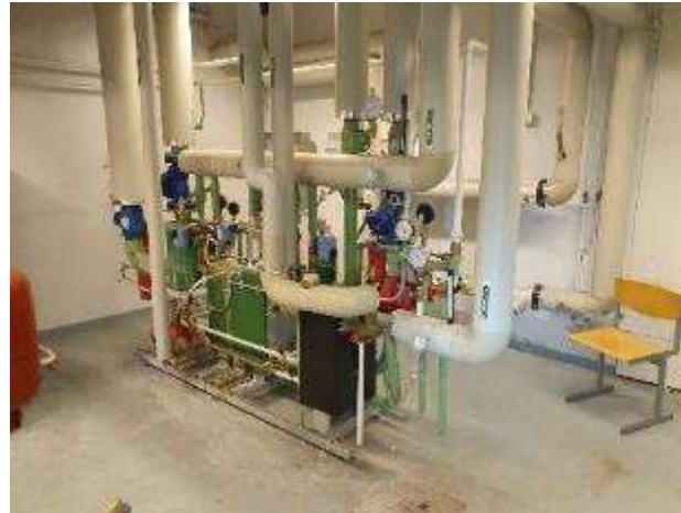
KUVA 83 2003 UUSITTU KAUKOLÄMMÖSIIRIN.
