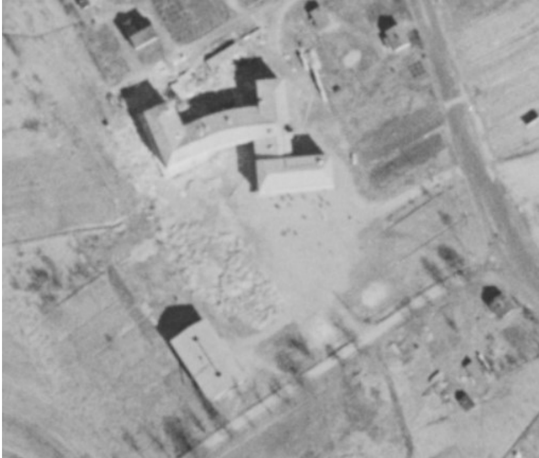
KUVA 15 LUKIORAKENNUS ON KOKONAISUUDESSAAN VALMIS. ILMAKUVA ON VUODELTA 1963.
