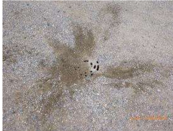
KUVA 92 SADEVESIKAIVO TÄYTYY PIHAHIEKASTA.
