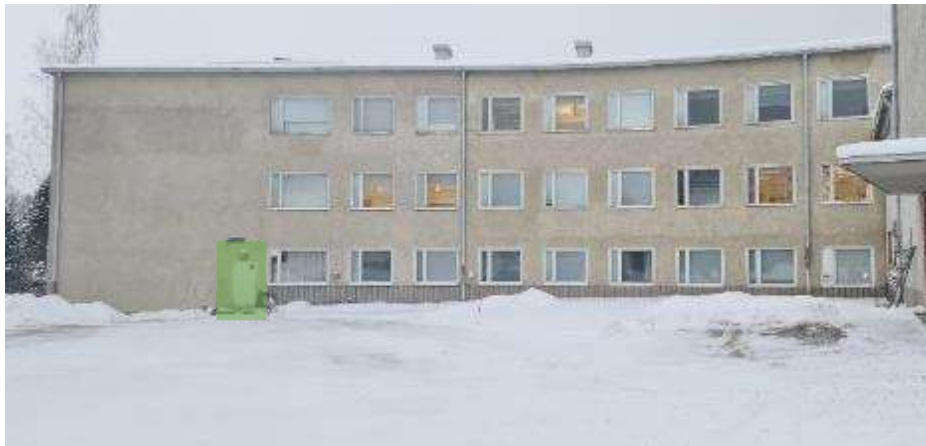
KUVA 33 ULKO-OVI RAKENNETTU ULKOSEINÄÄN KEITTIÖN TYÖNTEKIJÖITÄ JA RUOKAHUOLTOA VARTEN MITÄ ILMEISIMMIN 1990-LUVULLA.
