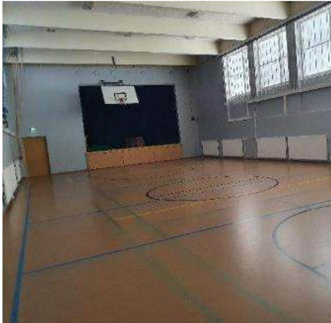
KUVA 53 VOIMISTELUSALIN LATTIA UUSITTU 2003 REMONTIN YHTEYDESSÄ SAMALLA MAALATTU SEINÄT JA ASENNETTU UUDET RADIAATTORIT.
