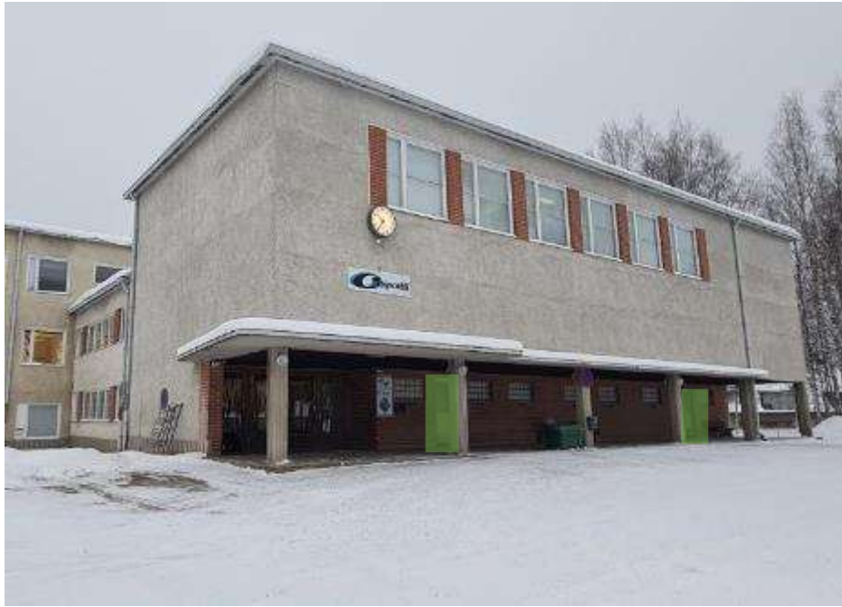
KUVA 35 WC- TILOJEN ULKO-OVET ON UUSITTU VUODEN 2003 REMONTIN YHTEYDESSÄ.
