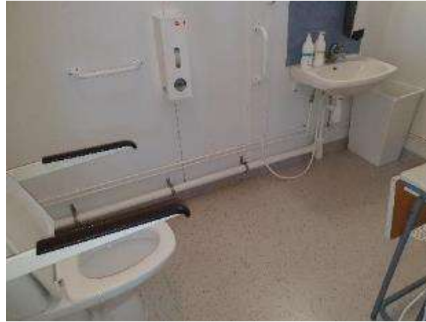
KUVA 66 1. KERROKSEN INVA-WC:N PINNAT JA KALUSTEET UUSITTU 2003.
