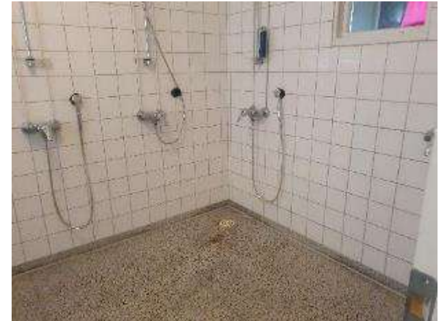
KUVA 56 VOIMISTELUSALIN PUKUHUONEEN YHTEYDESSÄ OLEVA PESUHUONE ON LÄHES ALKUPERÄISESSÄ KUNNOSSA.
