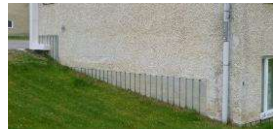
KUVA 87 LÄNSIPÄÄDYSSÄ MAANPINTA VIETTÄÄ RAKENNUKSEEN PÄIN.
