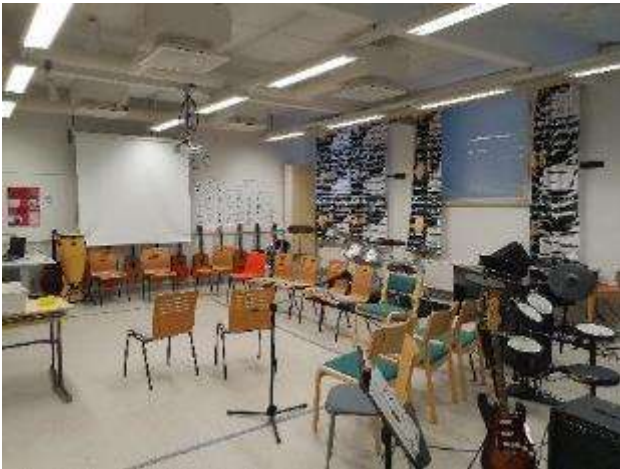
KUVA 65 "MANALAN" MUSIIKKILUOKKAAN RAKENNETTU MAAPERÄKOSTEUDEN VUOKSI TUULETTUVA LATTIA.
