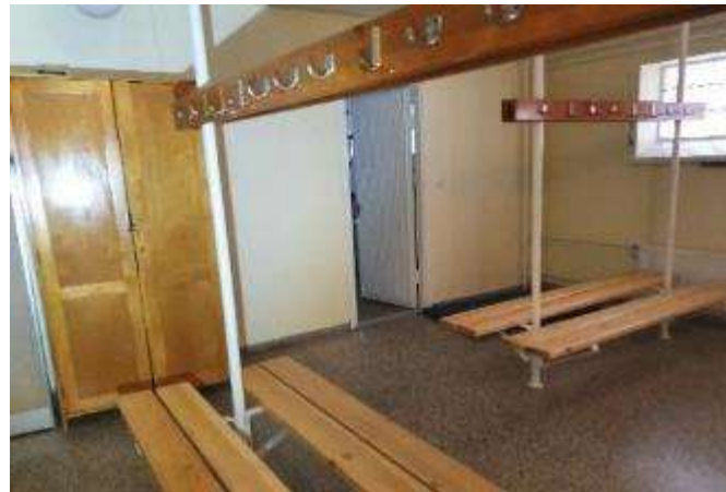
KUVA 55 VOIMISTELUSALIN PUKUHUONE ALKUPERÄISESSÄ KUNNOSSA.
