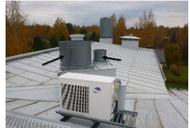
KUVA 47 VESIKATOLLA UUSIA LÄPIVIENTEJÄ JA LAITTEITA
