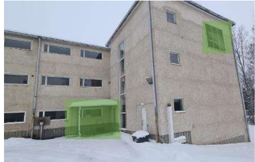
KUVA 37 ILMANVAIHDON ULKOSÄLEIKKÖ TEHTY ULKOSEINÄÄN VUODEN 2003 REMONTISSA.
