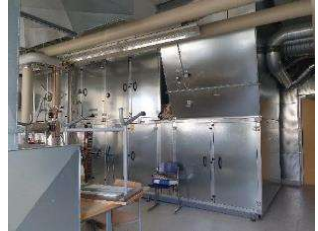
KUVA 78 2003 REMONTISSA UUSITTU ILMANVAIHTOKONE.
