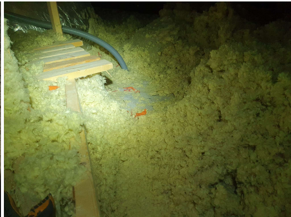
Alkuperäisen osan yläpohjarakennetta Laajennusosalla eristeenä mineraalivilla
