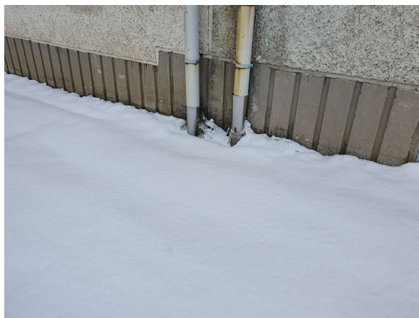
Vedet ohjattu suoraan sadevesiviemäriin
