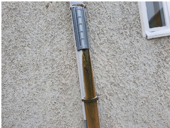
Syöksytörvien tarkastusluukkujen kohdalla vuotojälkiä
