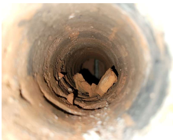
Ulkoverhoustiilen sisäpinta näkyvillä
