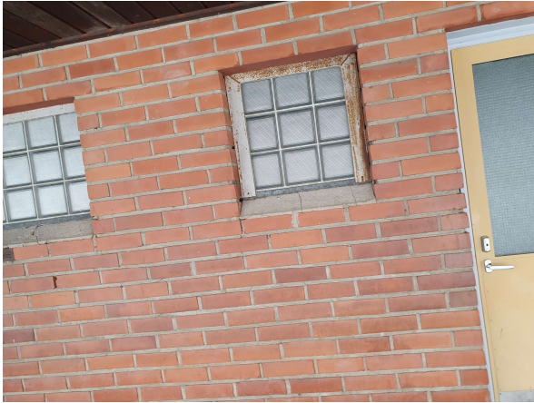
Wc-tilojen lasitiili-ikkunat katoksessa.
