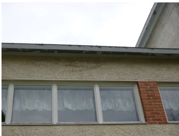
Rästääät ovat lyhyet. Puolet räystäään mitasta koostuu räystäskourusta.
