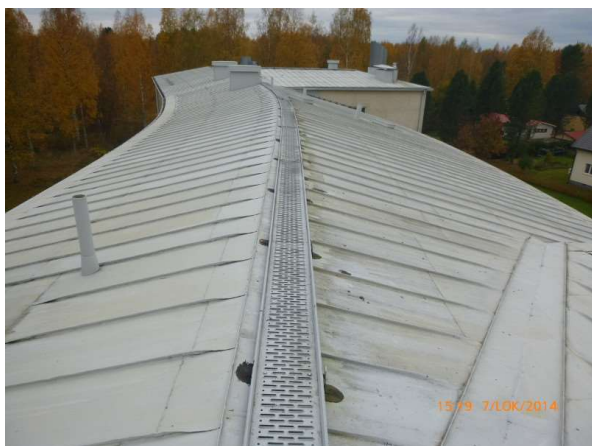
Kulkusiltojen kiinnitykset pellistä läpi (kuva vuodelta 2014)
