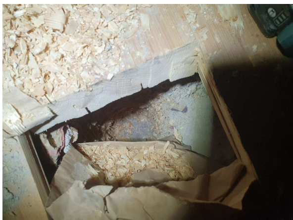
Liikuntasalin lattian rakenneavaus
