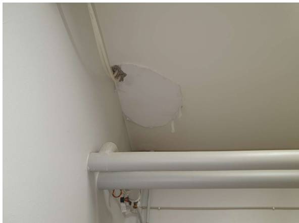
Katon maalipinta irti
