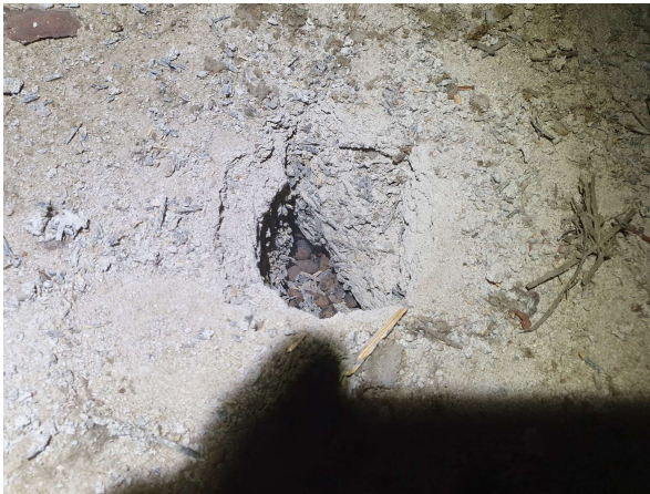
Alkuperäisen osan yläpohjarakennetta Laajennusosalla eristeenä mineraalivilla
