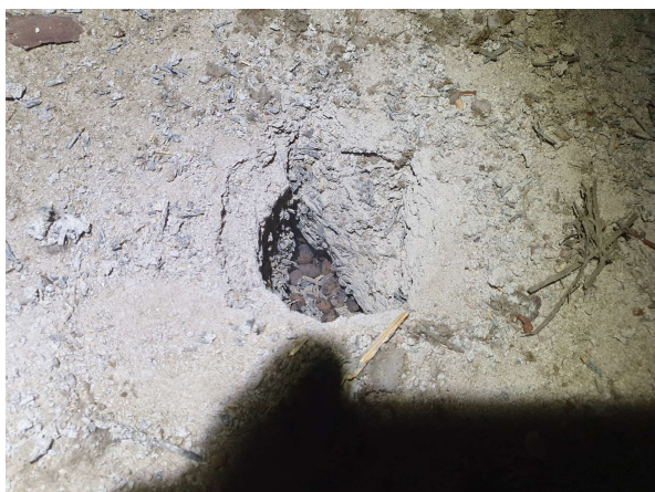
Alkuperäisen osan yläpohjarakennetta
