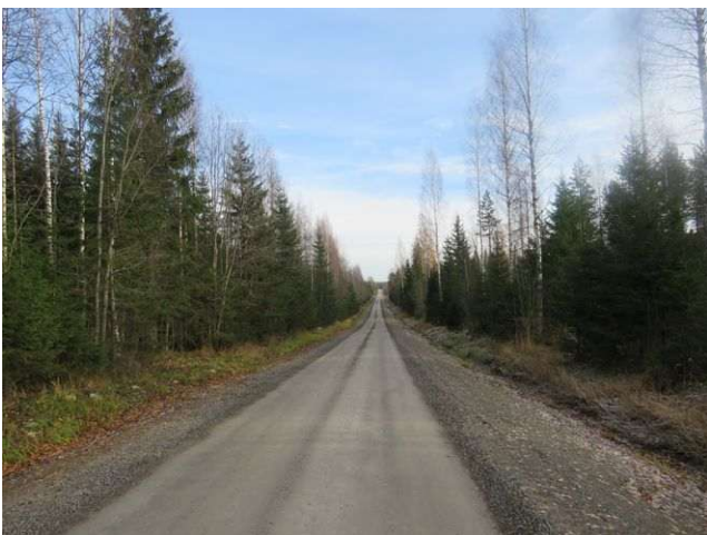
Kuva 28. Tien ylitys Lapinsalon kohdalla, länteen.
