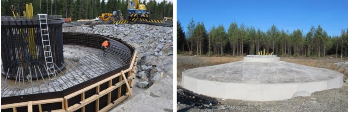
Kuva 89. Tuulivoimalan perustusten rakentamista (FCG Finnish Consulting Group Oy).
