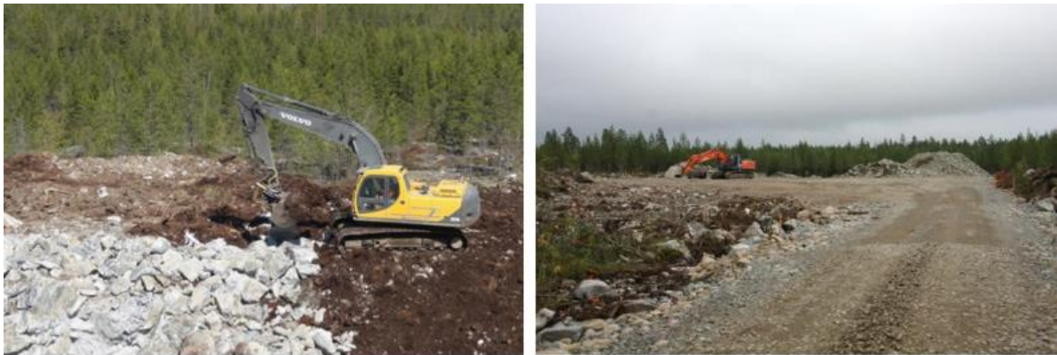
Kuva 87. Tuulivoimapuiston rakentaminen alkaa huoltoteiden ja pystytysalueiden rakentamisella (FCG Finnish Consulting Group Oy).
