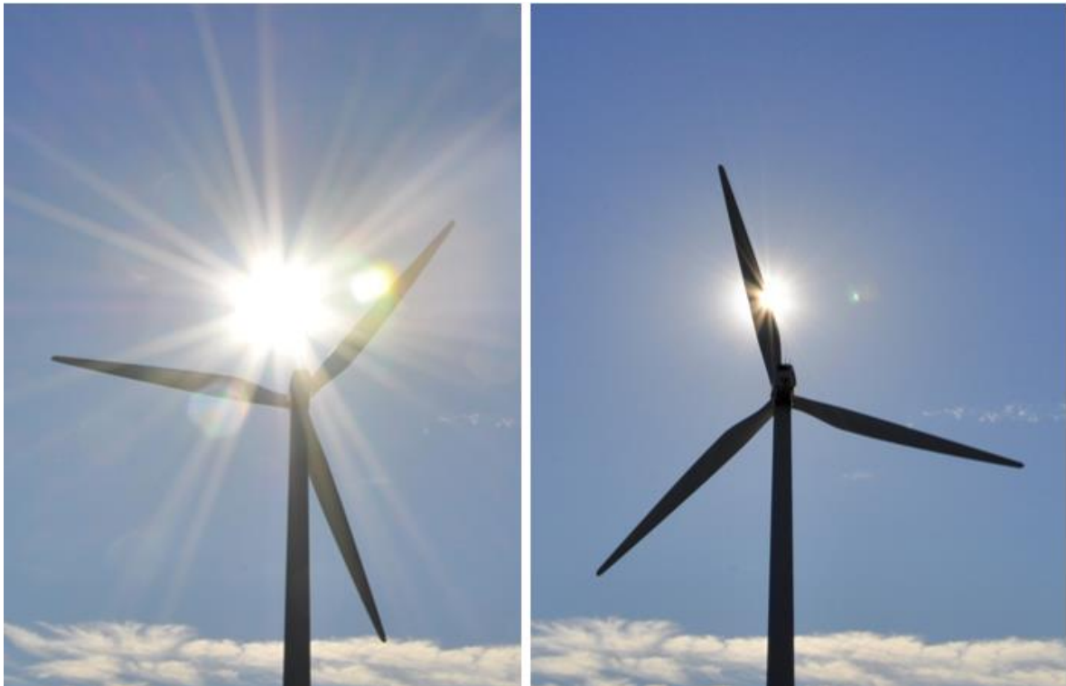
Kuva 70. Tuulivoimaloiden lavat aiheuttavat pyöriessään vilkkumista ja varjon välkkymistä aurinkoisella säällä.
