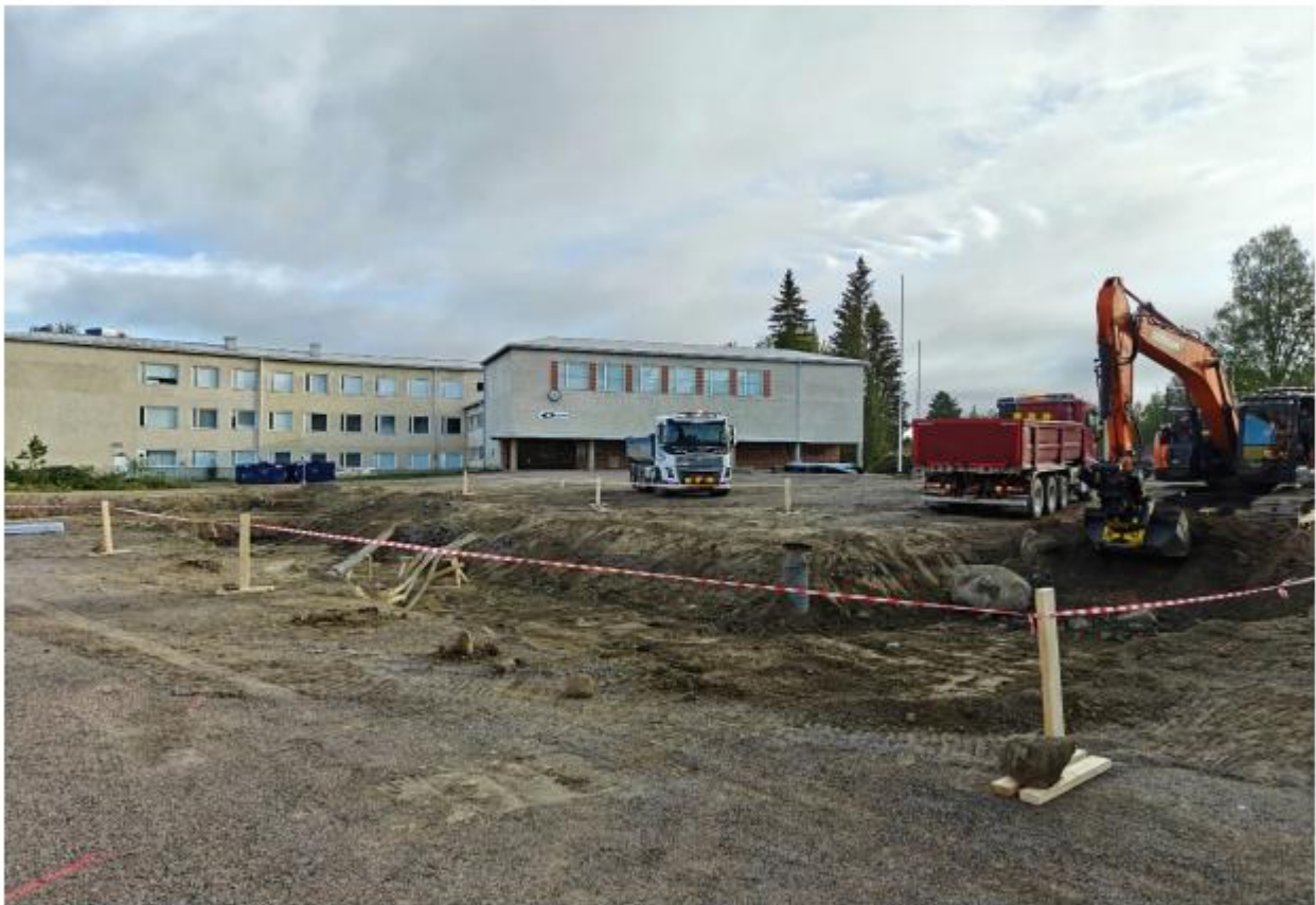
Kuva: Vko 33/ 2025 VSS, liikuntahallin perustuslinjojen kaivut menossa (Lähde: Lujatalo Oy)
