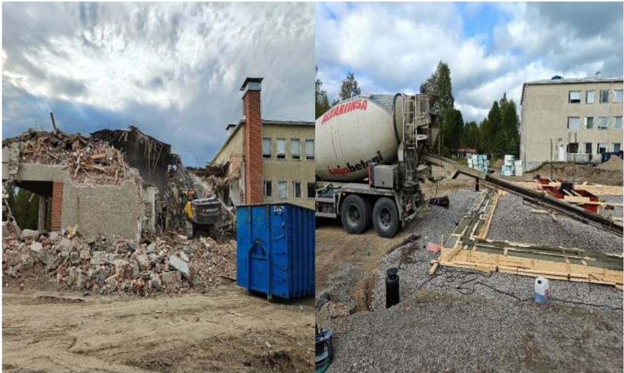
Kuva: Vko 36/ 2025 Purettavan osan purku menossa, ensimmäiset anturat valettu (Lähde: Lujatalo Oy)
