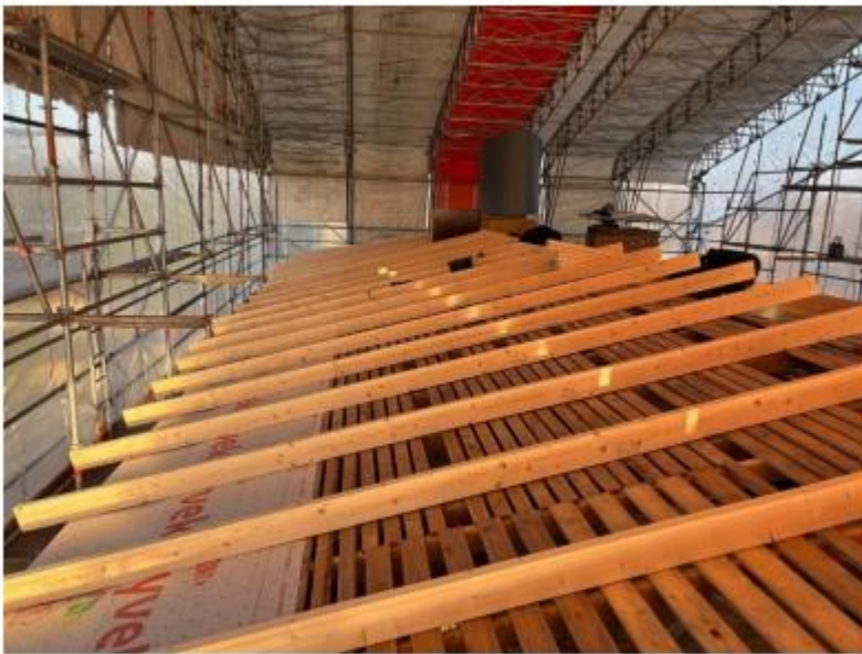
Kuva: Vko 44/ 2025 Saneerausosan kattotyöt (Lähde: Lujatalo Oy)
