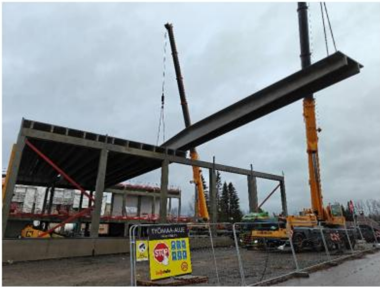
Kuva: Vko 46/ 2025 HTT-laattojen asennus (Lujatalo Oy)
