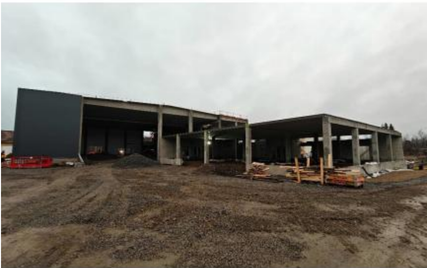
Kuva: Vko 49/ 2025 Kirjaston betonirunko asennettu (Lujatalo Oy)
