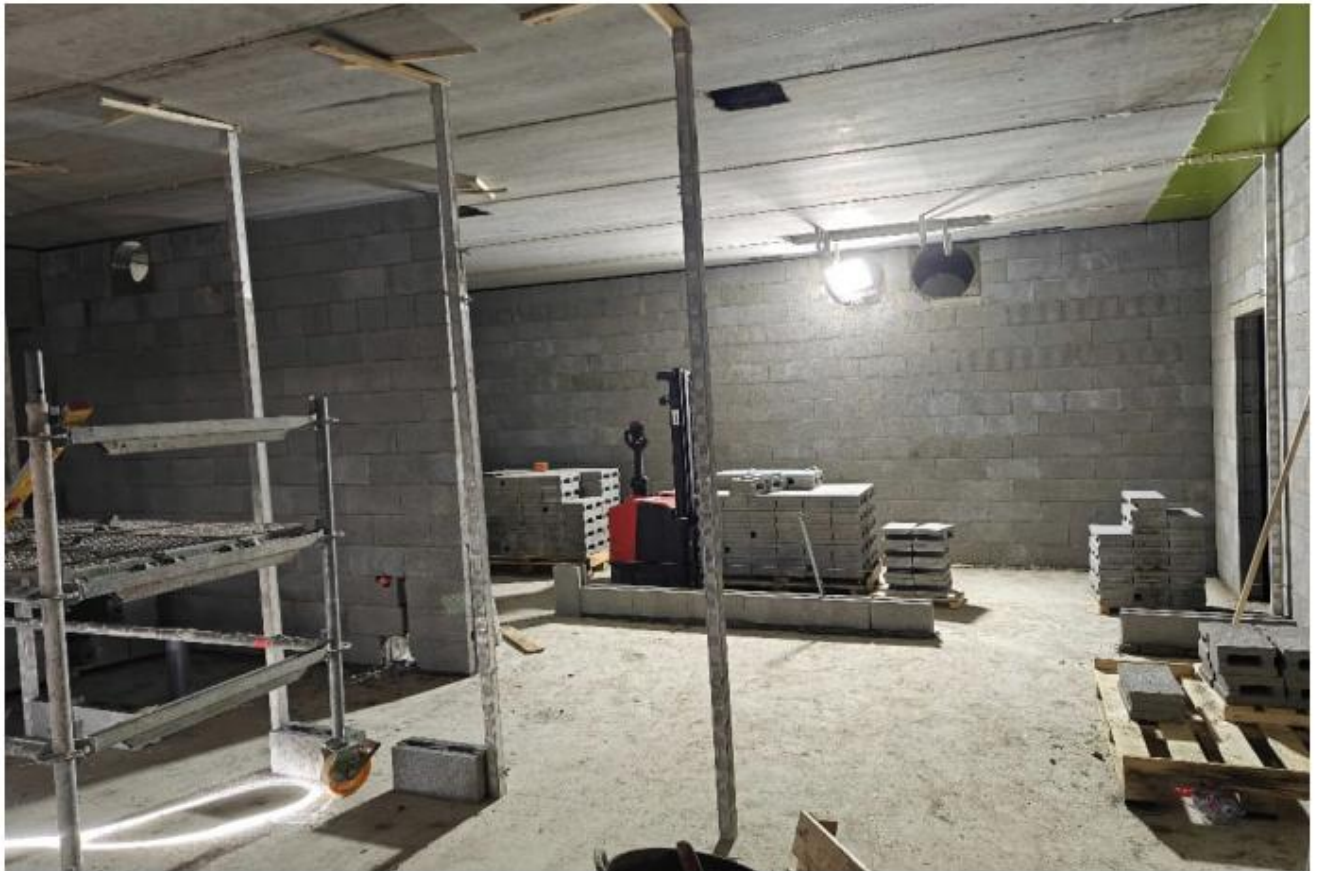
Kuva: Vko 7/ 2026 Liikuntahallin 1. kerroksen väliseinämuuraukset (Lujatalo Oy)
