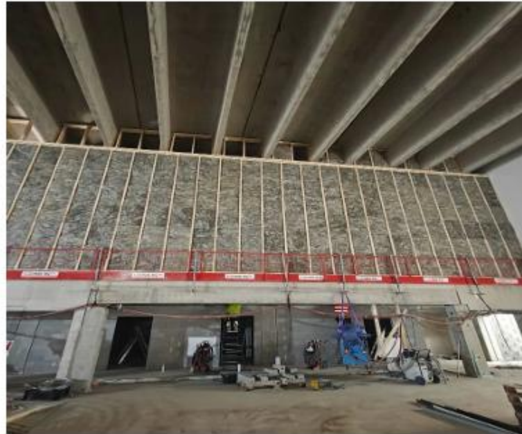
Kuva: Vko 13/ 2026 Liikuntasali 1–2 krs. rajapintaan seinän tekoa (Lujatalo Oy)
