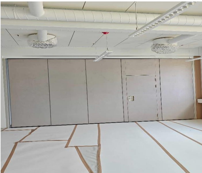
Kuva: Vko 24/2026 Saneerausosalla siirtoseinät asennettu (Lujatalo Oy)
