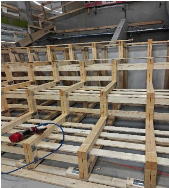
Kuva: Vko 35/2026 Opinportaiden runkotyöt (Lujatalo Oy)
