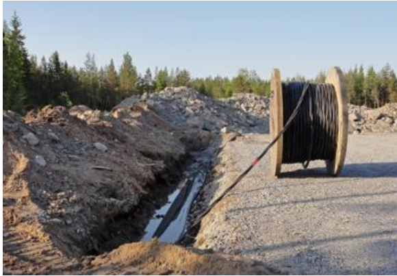
Kuva 89. Maakaapelit upotetaan huoltoteiden yhteyteen (FCG Finnish Consulting Group Oy).
