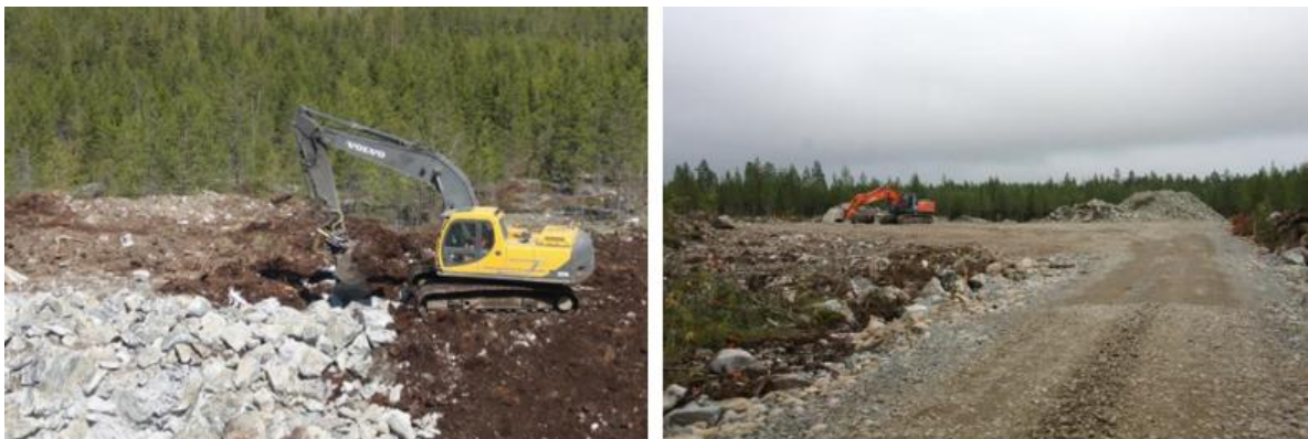
Kuva 88. Tuulivoimapuiston rakentaminen alkaa huoltoteiden ja pystytysalueiden rakentamisella (FCG Finnish Consulting Group Oy).
