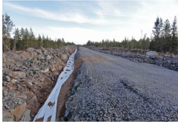
Kuva 89. Maakaapelit upotetaan huoltoteiden yhteyteen (FCG Finnish Consulting Group Oy).
