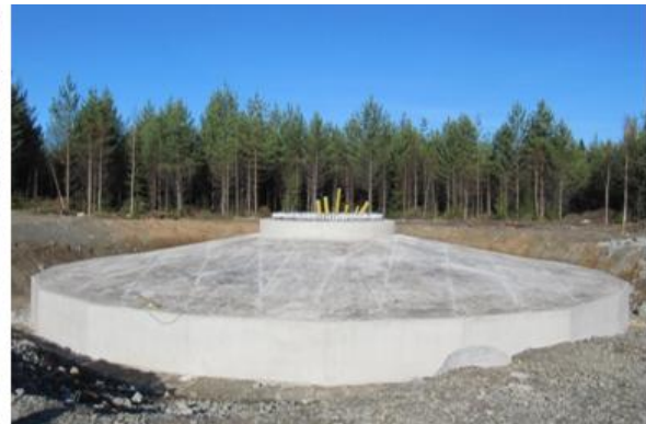
Kuva 90. Tuulivoimalan perustusten rakentamista (FCG Finnish Consulting Group Oy).
