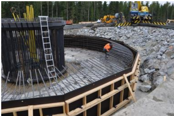
Kuva 90. Tuulivoimalan perustusten rakentamista (FCG Finnish Consulting Group Oy).
