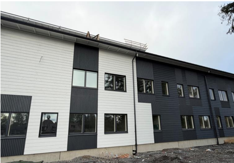
Kuva: Vko 38/2026 Julkisivu itään (Lujatalo Oy)
